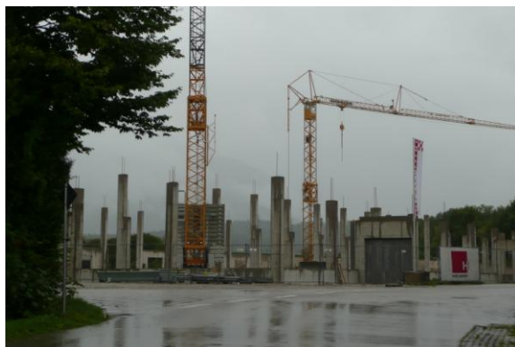
Impressionen vom Bau der künftigen ICS Logistikhalle (ca. 13 m hoch) in Türk im September 2017
